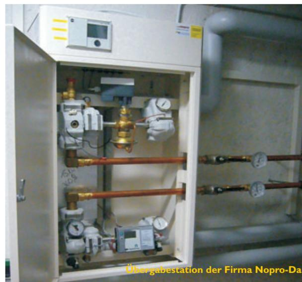
Die Regelung ist mit dem Wärmemengenzähler gekoppelt und über eine Datenleitung mit der Heizzentrale verbunden. Damit lässt sich die Wärmeabnahme jedes einzelnen Abnehmers zentral erfassen und speichern. Der Missbrauch in der Verwendung der Übergabestation kann somit in der Heizzentrale festgestellt werden.
